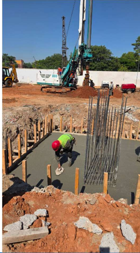
Armado, cargamento y desencofrado de cabezales
