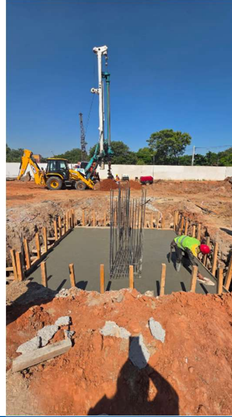
Armado, cargamento y desencofrado de cabezales
